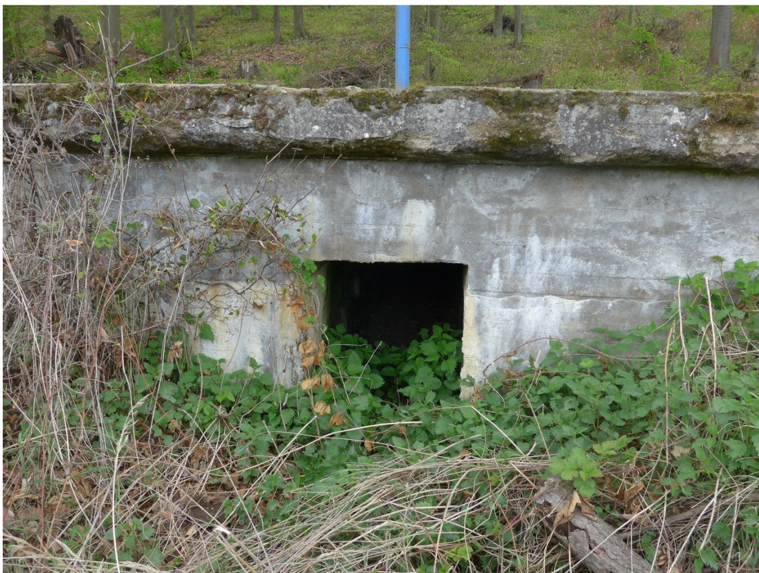
Propustek u kterého levá strana TB skončí
