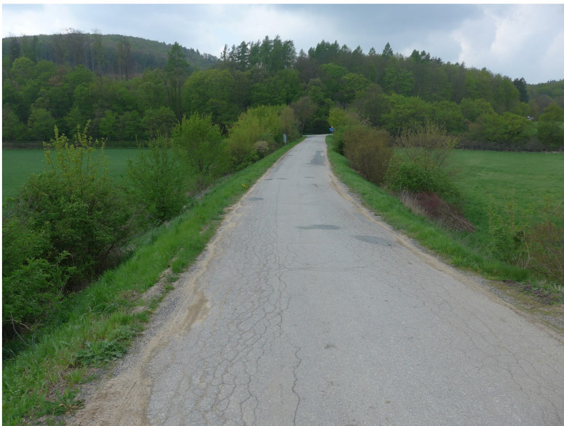
Trasa TB od přechodu pro obojživelníky směrem k železničnímu přejezdu
