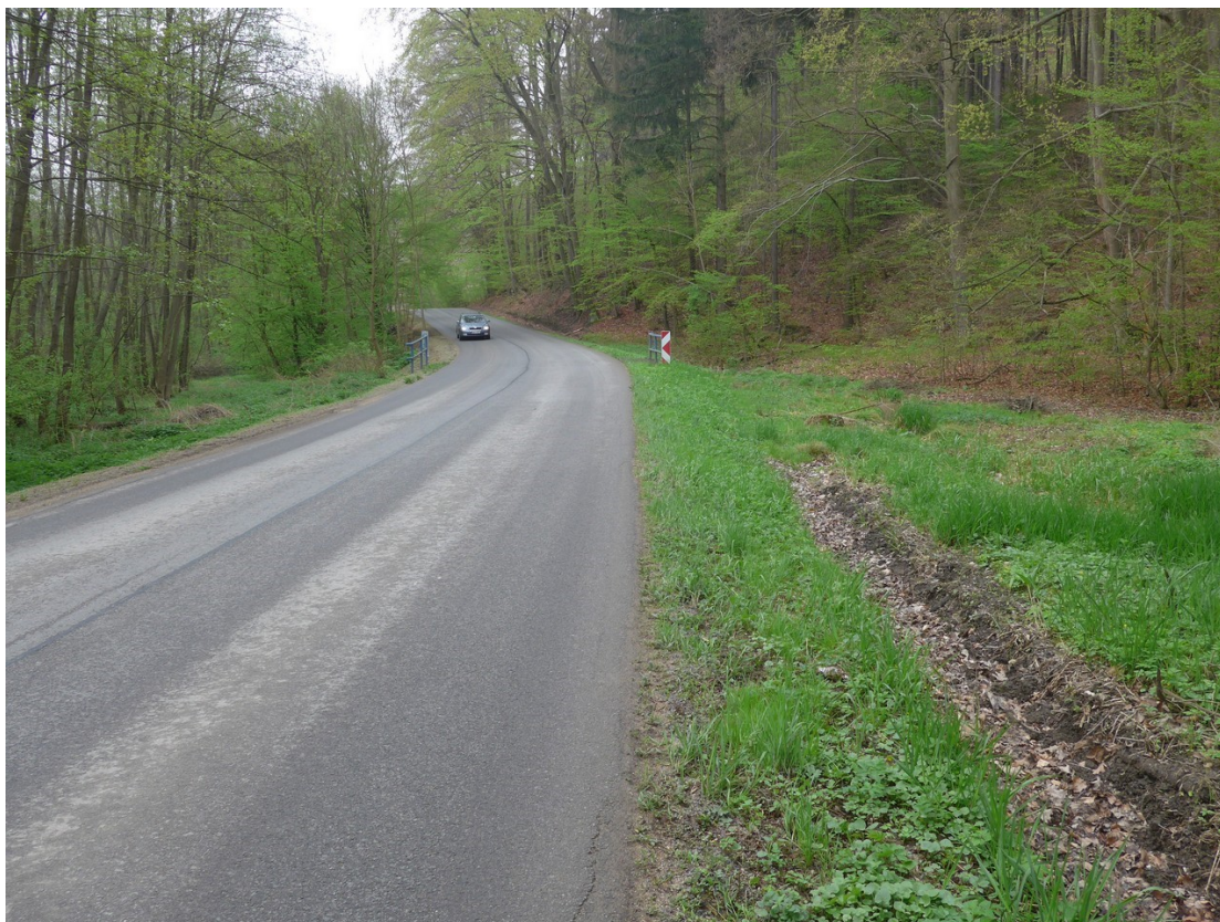
Pohled na další propustek
