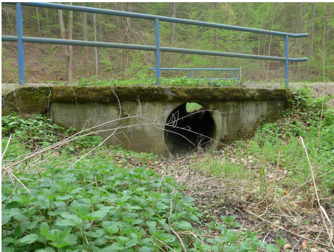
Funkční propustek na trase levé strany
