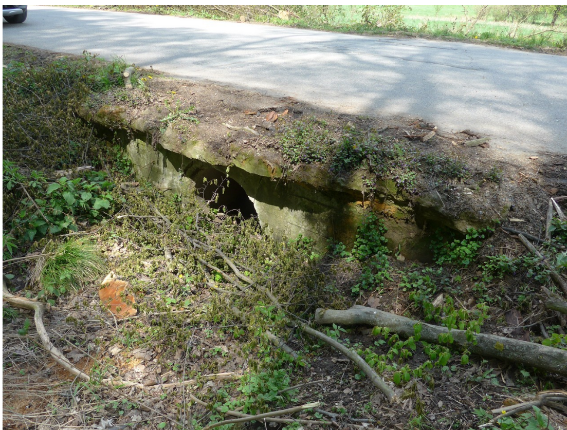
Pohled na propustek z pravé strany
