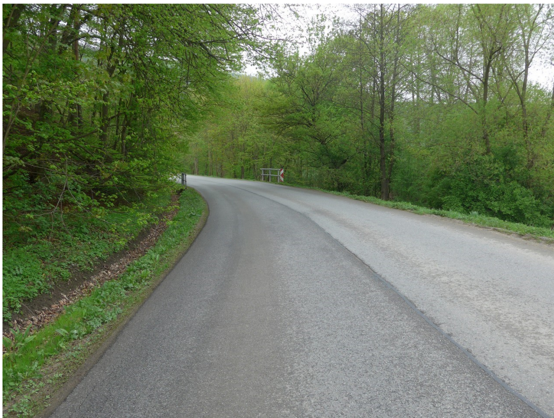
Pohled na stejný propustek z druhé strany
