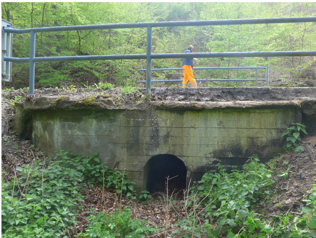
Další funkční propustek na levé straně
