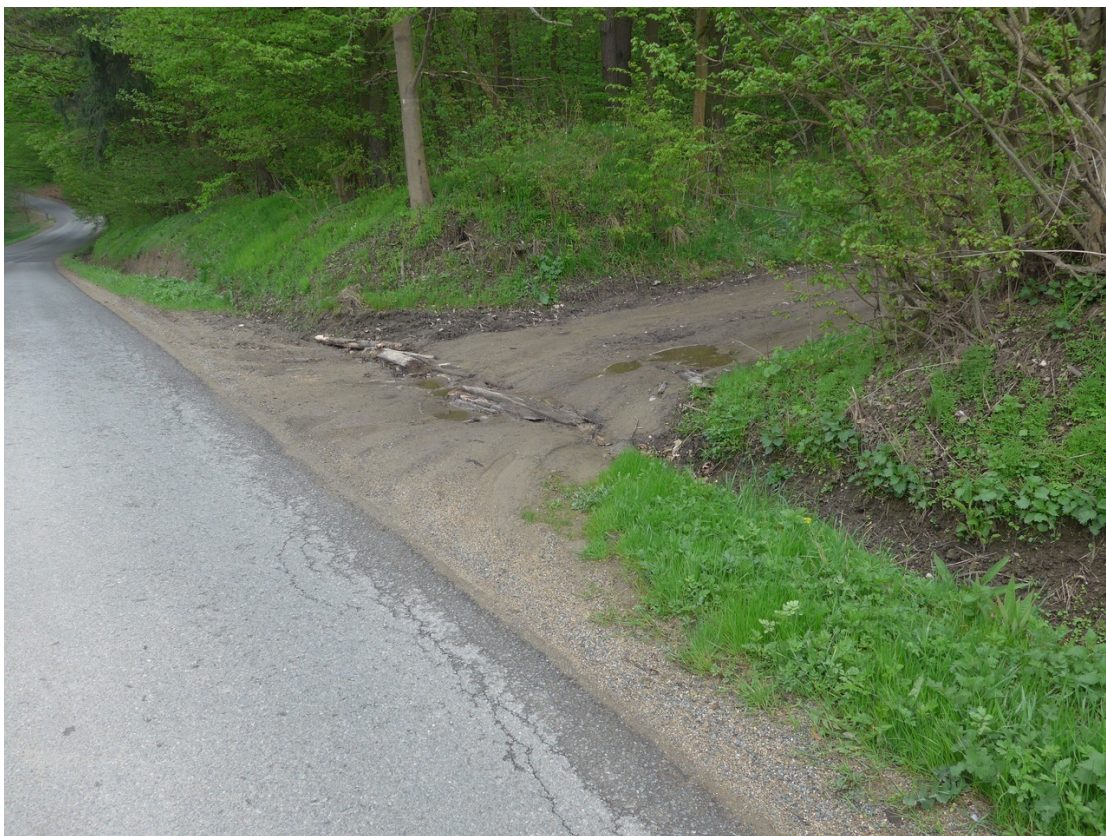
Sjezd na lesní cestu ošetřený pomocí tubosideru
