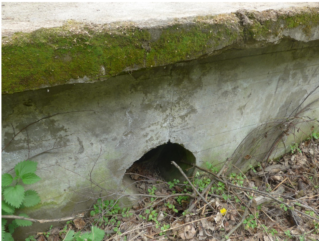
Pravá strana stejného propustku
