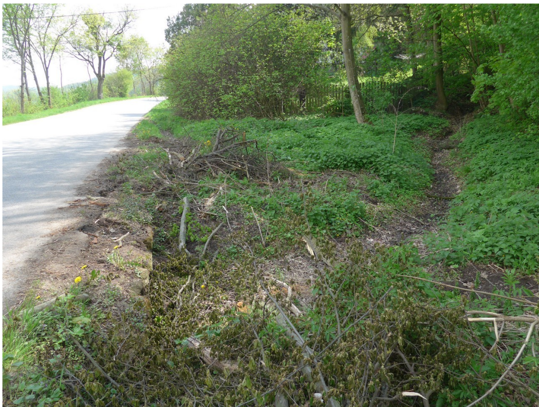
Poslední propustek na trase
