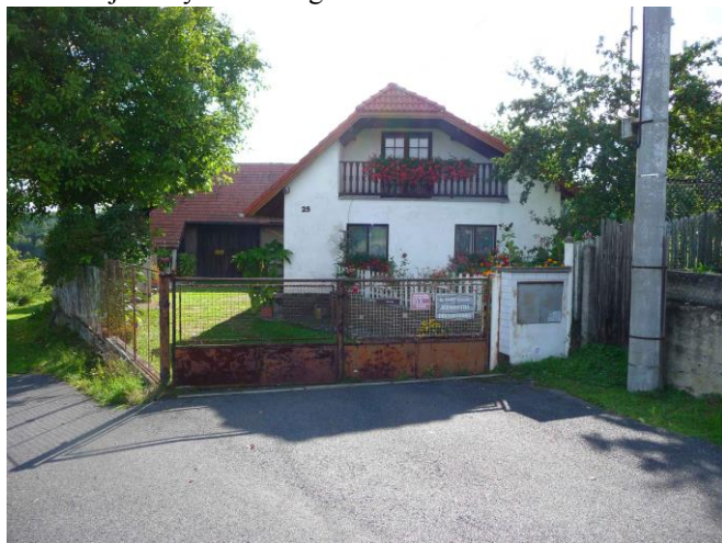
obr. č. C.135: Necitlivá a nevkusná přestavba - zejména horní část štítu s velkou trojicí oken a svislým obkladem poškodila původní výraz
