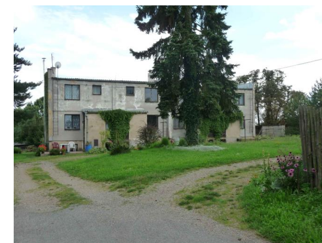
obr. č. C.812: Menší bytový dům poplatný době svého vzniku - cca ze začátku 80. let minulého století
