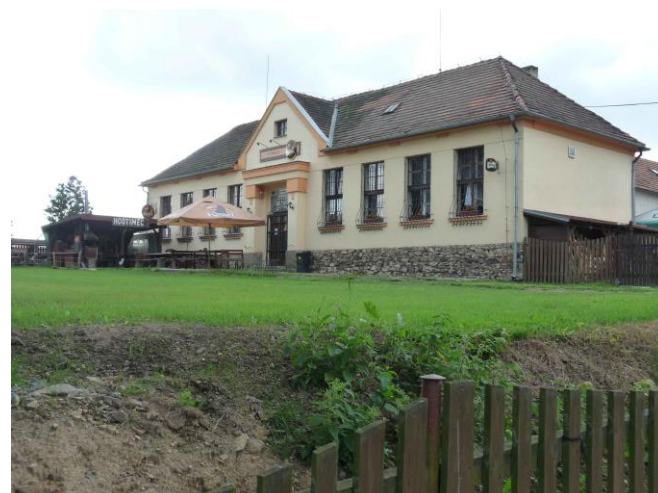
obr. č. C.434: V sídle výrazně se uplatňující symetrická budova hostince, díky užití vhodných oken s výtvarně pojednanými mřížemi a pomocí dominantně řešeného průčelí s vystupujícím trojúhelníkovým štítem je jinak jednoduchá hmota povýšena na reprezentativní stavbu
