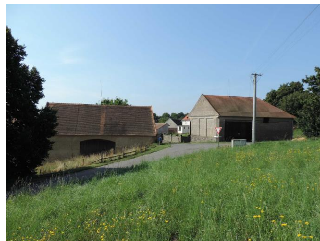
obr. č. C.769: Výrazná hmota bytového domu s valbvu střechou ve východní části sídla
