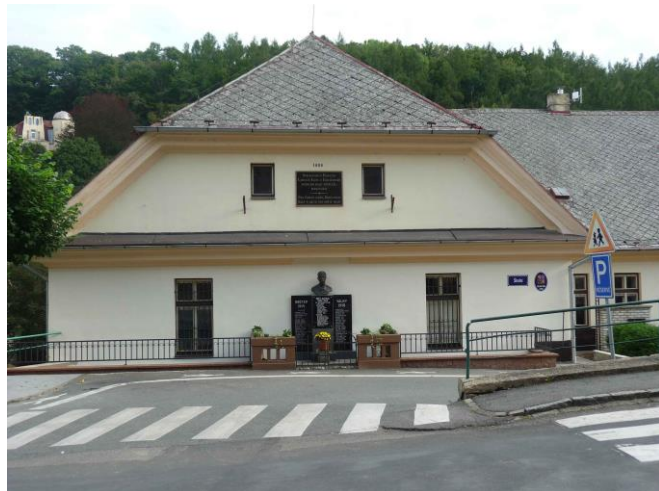
obr. č. C.413: Celkem zdařile byla provedena obnova objektu hospody na severním konci mostu, zajímavě působí skladba valbových střech a jejich vzájemné napojení i barevné zjemnění světlejšími pásy hran, říms a nadokenních pásů
