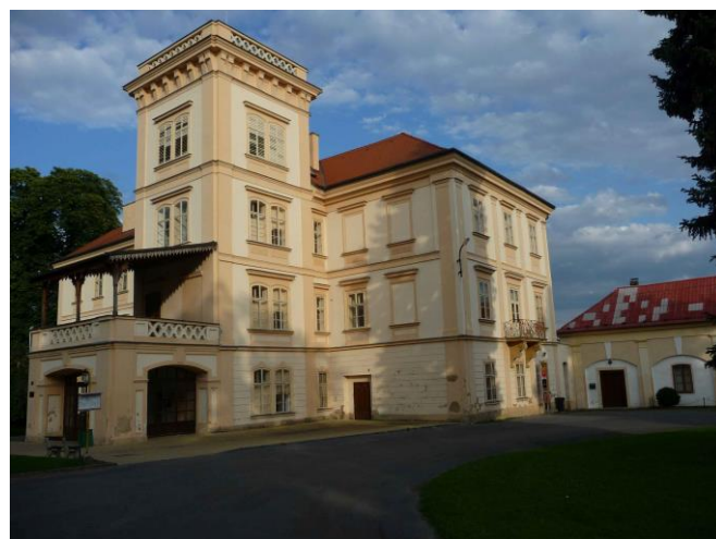
obr. č. C.604: Obdélníkový dvoupatrový budova zámku, z níž při severním průčelí vystupuje třípatrová hranolová věž upravená do empírové podoby a portikus
