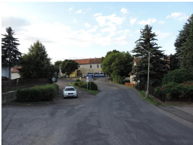
obr. č. C.60: Jednotná zástavba štítově orientovaných usedlostí na obdélném půdorysu respektující uliční čaru v severovýchodní části sídla
