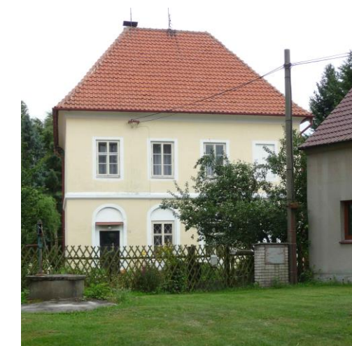
obr. č. C.369: Dvoupatrový objekt bývalé školy s vysokou valbovou střechou; zdařile obnovená fasáda se zachováním plastického členění římsou i okenních šambrán
