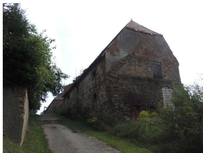
obr. č. C.194: Monumentální hmota dvora u zámku tvořící jednu z dominant sídla; Cenné je uspořádání staveb, jejich tvary i zapojení v terénu
