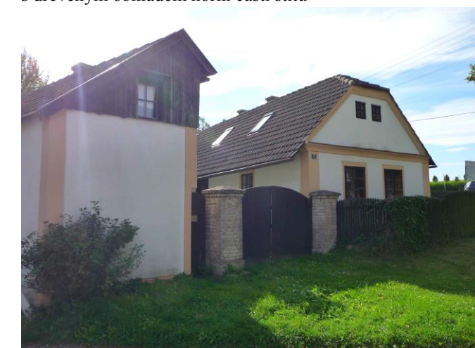
obr. č. C.132: Vkusně obnovená venkovská usedlost; sjednocení výrazu napomáhá barevné členění; zajímavou zvláštností je asymetrické ukončení jakoby useknuté střechy s dřevěným obkladem horní části štítu
