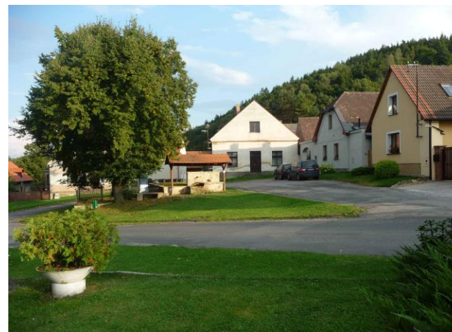
obr. č. C.621: Podobné tvary domků ve svahu a jejich těsné nahodilé uspořádání tvoří zajímavou, příznivě vnímanou kompozici v údolíčku vyběhající z návsi na jihozápad
