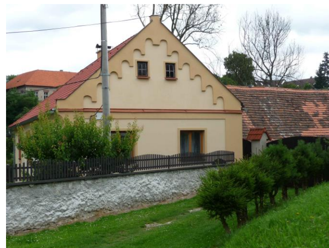
obr. č. C.780: Budova sokolovny s účelově zvýrazněným zvlněným štítem v symetrické poloze, výraz stavby charakterizuje její veřejnou funkci, užité prvky a zřejmě pozdější úpravy jsou ale nejednotné a rušivé
