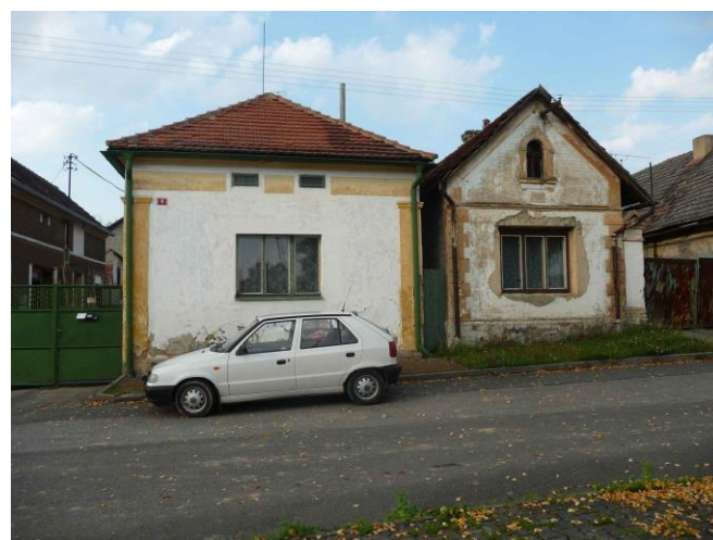
obr. č. C.283: Zdobný štít s výtvarně vhodně přiznaným krovem (krokve, pozednice i kleština), s plastickým a barevným zvýrazněním fasády, příznivý dojem doplňuje okrasná předzahrádka
