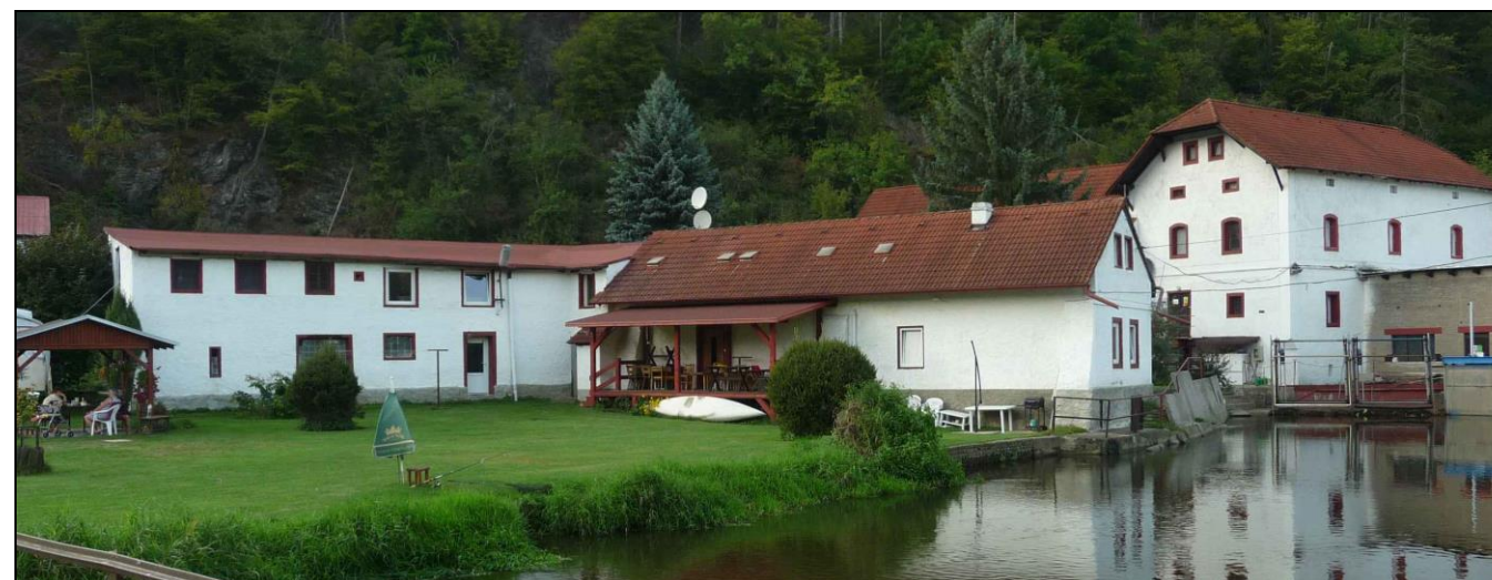
obr. č. C.666 Elektroskanzen Čechův mlýn je soubor několika různorodých objektů, nejvíce se z harmonicky vyhlížející skupiny vymyká nejnovější část vlevo s plochou střechou, avšak díky jednotnému barevnému řešení a okrajové poloze lze i tuto stavbu akceptovat
