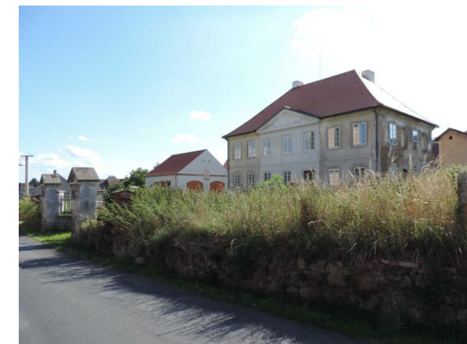
obr. č. C.107: Dominantní dvoupatrový objekt bývalé fary stojící naproti kostelu, s přilehlým hospodářským dvorem. Jednoduchý tvar, symetrické uspořádání, jasná funkčnost a kompozice jsou zárukou kvalitního výrazu.
