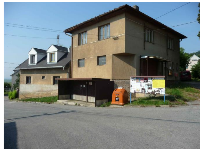
obr. č. C.242: Dům tradiční jednoduché hmoty utrpěl výměnou oken, nečleněná čtvercová okna a menší okénko nad vstupem působí poněkud zvláště, alespoň částečného zlepšení výrazu by mohlo být dosaženo doplněním vnější parapetní římsy, příp. i nadokenní
