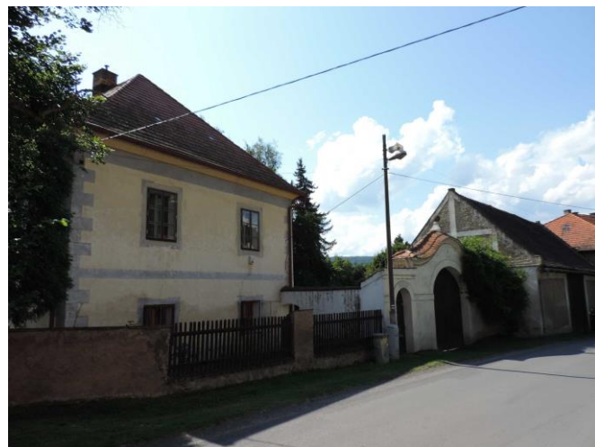
obr. č. C.786: Hodnotná patrová barokní fara z roku 1707 s valbovou střechou a bránou s brankou
