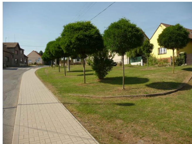
obr. č. C.305: Venkovská zástavba s valbovými střechami a barevně členěnými fasádami, u objektu vpravo došlo k nevhodné výměně oken (původní tvary a umístění je dosud patrné ze zachovaných šambrán)
