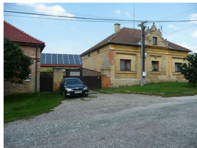
obr. č. C.50: Obvyklý nešvar minulých období, kdy kvalitní plasticky zdobená fasáda byla narušena nevhodným tvarem vyměněných oken; statek v severovýchodním rohu severní návsi
