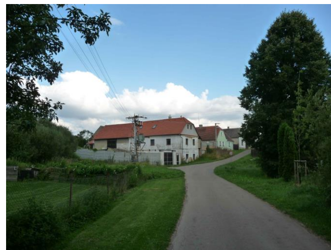
obr. č. C.437: Pohled na lihovar na východním okraji sídla, budova vpravo má valbové zastřešení mírného sklonu, budova částečně ztratila svoji hodnotu výměnou oken (patrně jsou rytmické obloukové rizality)
