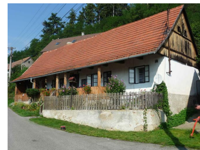
obr. č. C.237: Chalupa pod svahem s průběžnou pavlákou podél uliční fasády, k celkové útulnosti přispívají i detaily typu šestitabulkových oken otevíraných vně, vhodného oplocení, květinové výzdoby apod.
