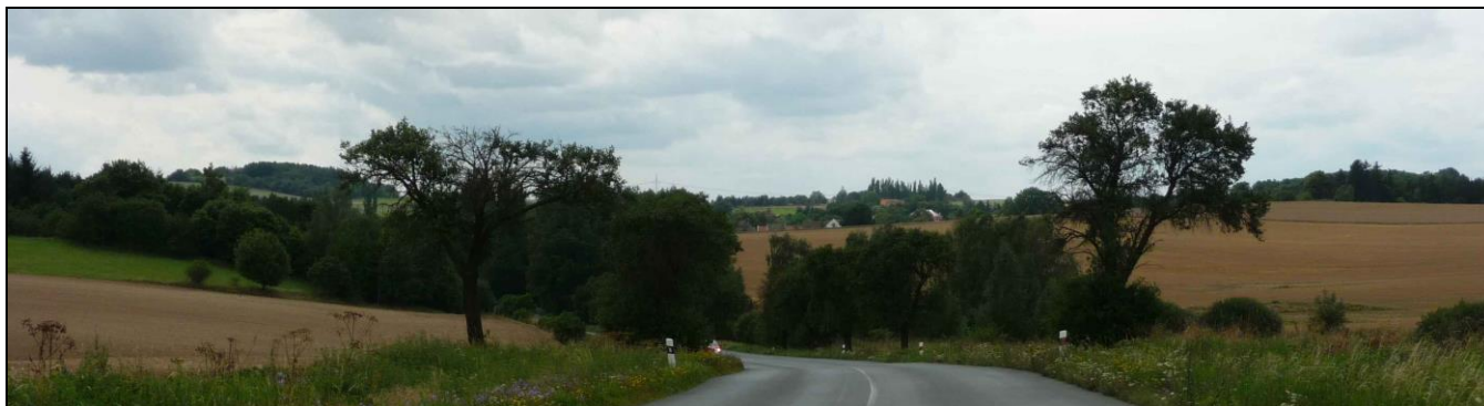
obr. č. C.477: Kostel Nanebevzetí P. Marie na návrší je lokální dominantou, pod ním objekt školy
