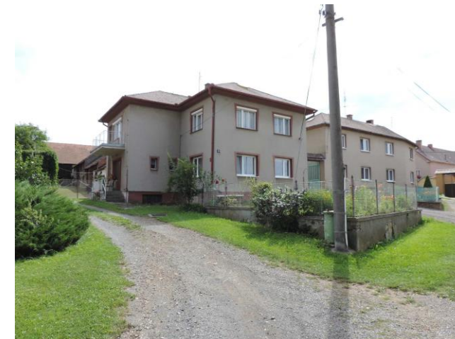
obr. č. C.379: Dvojice venkovských domů jako příklad nevhodné nástavby objektu vlevo; zvýšením o patro došlo ke ztrátě původního výrazu
