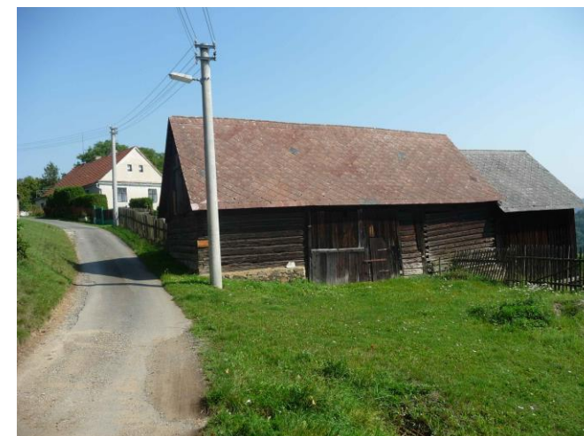
obr. č. C.402: Malebně působí obnovená fasáda historického domu se zajímavě a citlivě řešeným barevným zvýrazněním; vhodně je zde užito členění korunní a patrovou římsou
