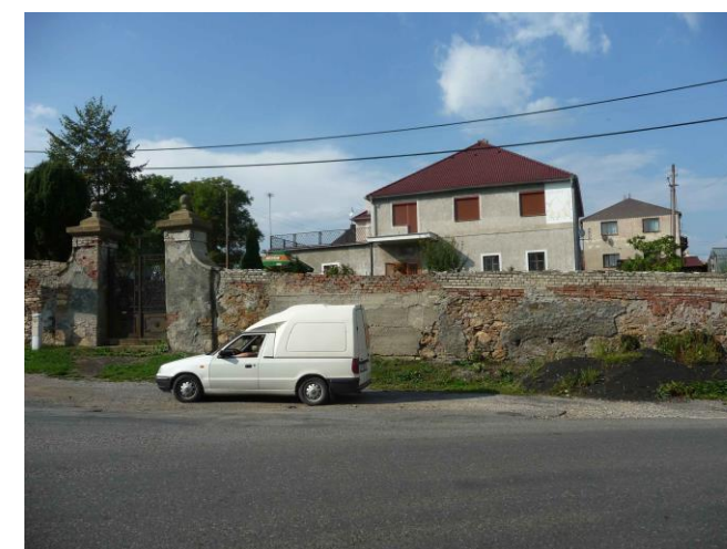
obr. č. C.172: Statek po výměně oken a obnově fasády působí neutrálním dojmem; příznivé je barevné sjednocení se zděnou bránou a zvýraznění průběžné podezdívky
