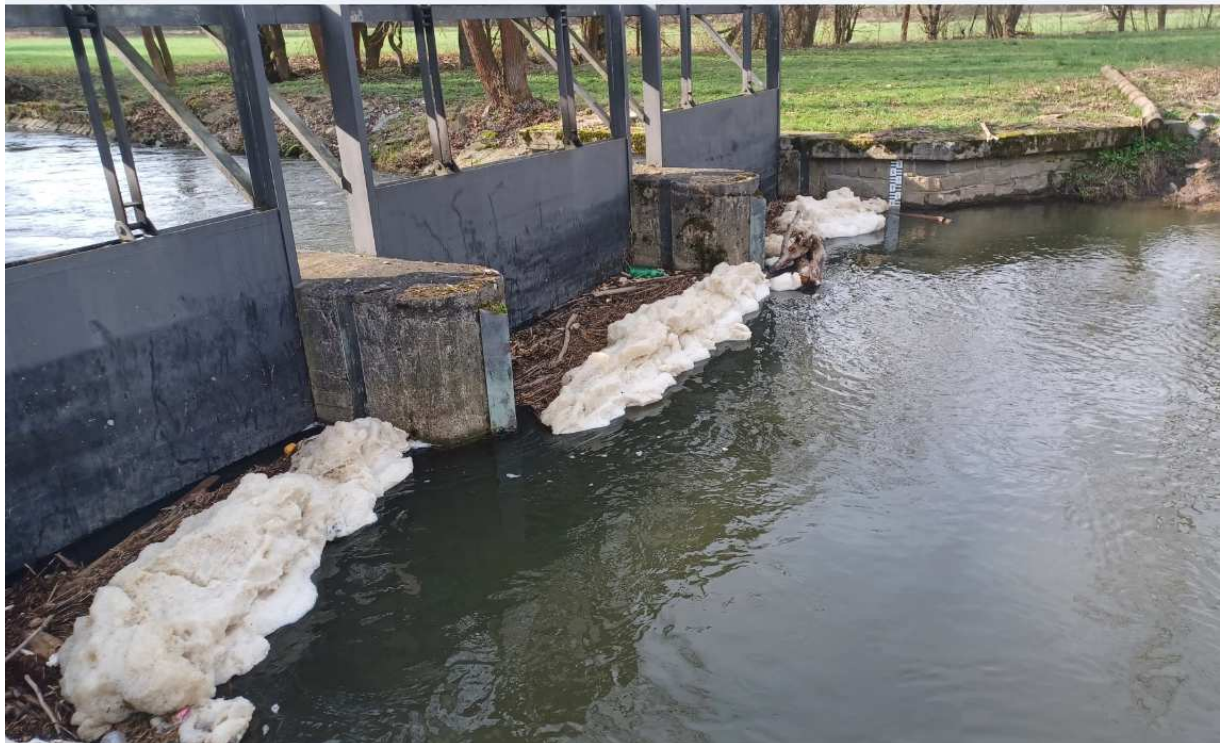
Foto 3: Vtoková stavidla do Malé Vody na jezu Řimice – záchyt pěny před stavidly.
